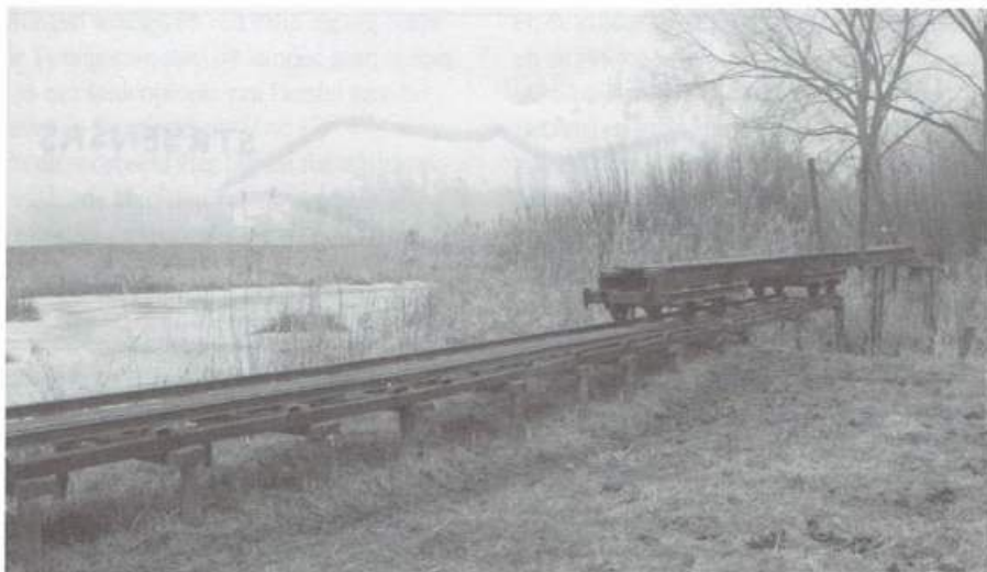
Rolbrug naar Esscheplaat
