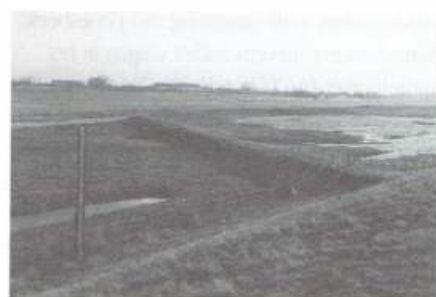
Een nog niet benut dijkje in de Stifse Waard
