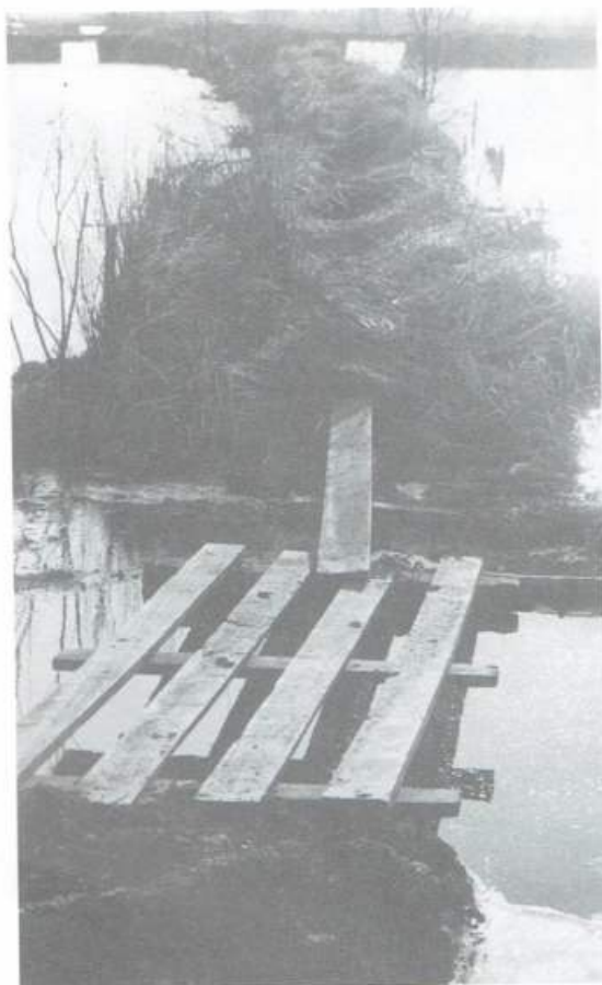
Door lobby van TeVoet zullen herstelwerkzaamheden worden verricht
