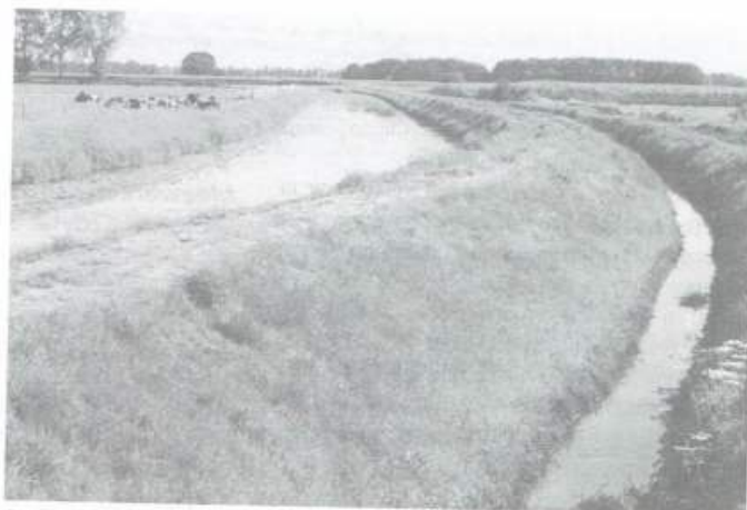
De Reusel, nog gekanaliseerd
