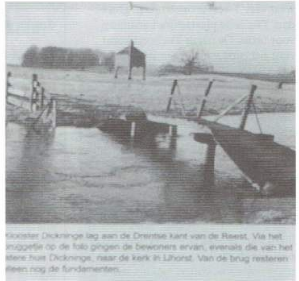
Van de brug naar Dickninge over De Reest resteren alleen nog de fundamenten
