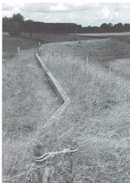
Waterkerend muurtje, na 1953 aangebracht
