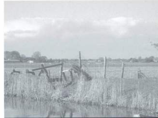
Enig achterstallig onderhoud
